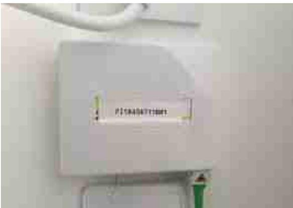
Selon les considérations pratiques ou esthétiques du client et après examen de l'habitation, les techniciens déterminent **le trajet le plus adapté** pour faire circuler la fibre jusqu'à la "**prise fibre optique**" terminale en utilisant l'un des fourreaux, les plinthes ou à travers la cloison. La prise fibre optique, petit boîtier blanc aussi appelé PTO (point de terminaison optique), est enfin soudée à la cloison.
